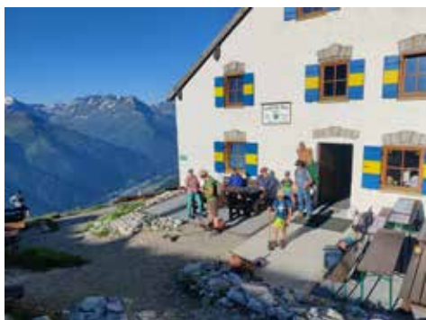
Gertrud, Robert, Herbert, Marco, Moritz, Burkhard und Samuel verlegen Wege
